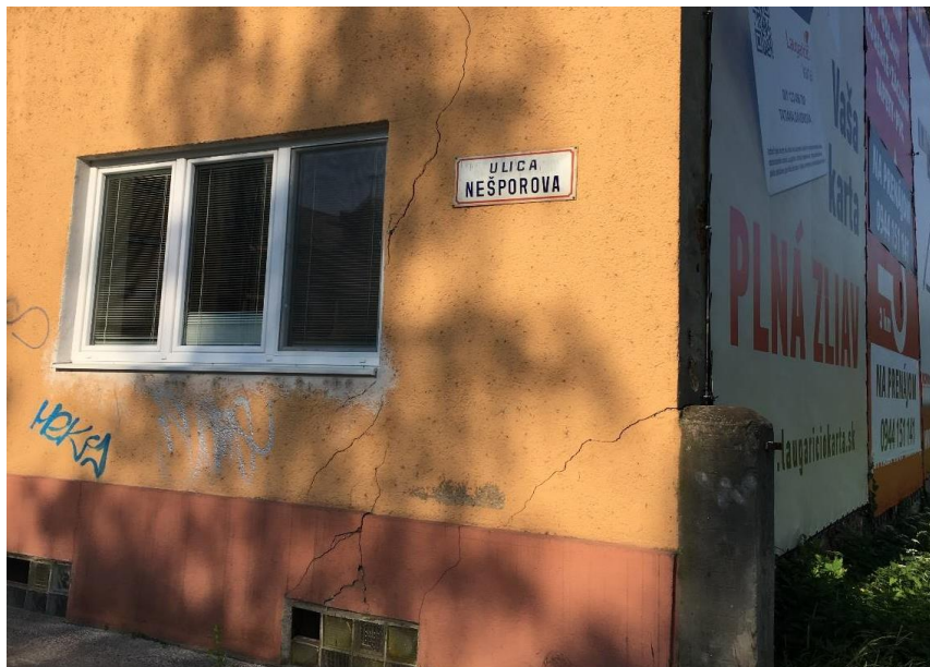
Obr.1 Zvislé trhliny obvodového nosného muriva v severovýchodnom nároží stavby spôsobené poklesom základovej škáry.
