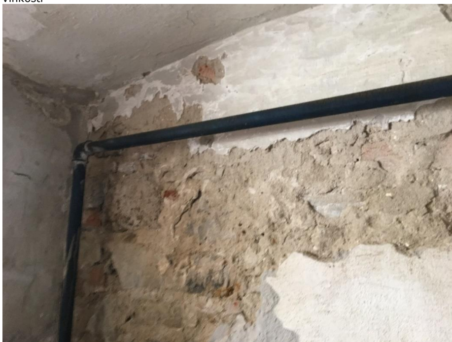
Obr.3 Cez obvodové steny suterénu bez zvislej hydroizolácie dochádza k presakovaniu zemnej vlhkosti do interiéru. V zmiešanom murive môže vlhkosť spôsobiť stratu únosnosti plnej pálenej tehly a následné statické poruchy.
