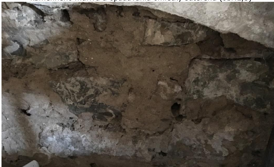
Obr.2 Stav nosného obvodového muriva suterénu spôsobený absenciou hydroizolácie proti zemnej a vzliňajúcej vlhkosti
