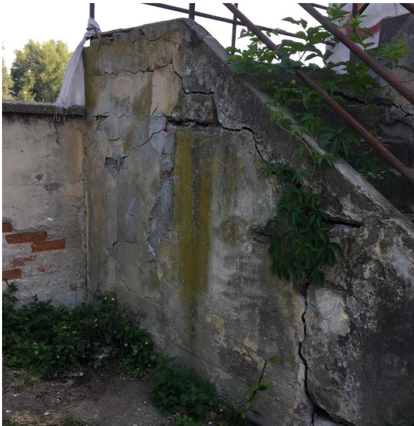
Obr.10 Pohľad na závažné narušenie nosnej konštrukcie exteriérového schodiska sprístupňujúceho povalový priestor.
