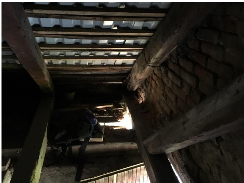
Obr.7 Pohľad na prehnitú konštrukciu krovu spôsobenú podtekaním vody pod krytinu v južnom rohu objektu.
