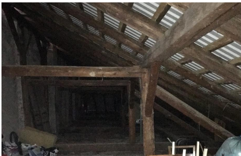
Obr.8 Pohľad na konštrukciu krovu dvorového krídla objektu. Priestor povaly je prístupný iba z exteriéru. V súčasnosti je využívaný iba čiastočne na skladovanie nábytku a nepotrebných vecí. Krov je dlhodobo neošetrovaný, lokálne sa objavujú prehnité časti.
