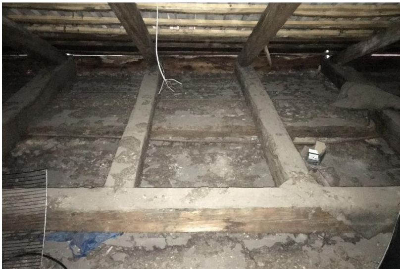
Obr.9 Konzolové trámy vkladané do výmeny medzi väznú trámu a nesúce vykonzolovanú časť strechy prekrývajúcu podstenu na južnej strane dvorového krídla. Na fotke vidno zdvojené latovanie – nedávno zrealizované nové latovanie kotvené vedľa pôvodného. Olemovanie konca pultovej strechy je značne prehnuté, zrejme z dôvodu chybného zrealizovaného alebo poškodeného ukončenia strechy.
