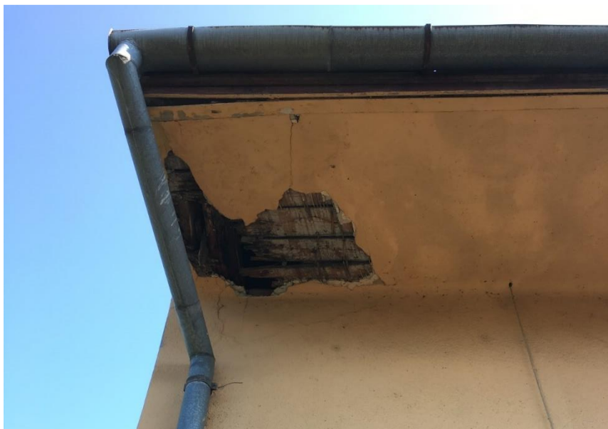
Obr.6 Na obrázku vidno prehnutie krokvy ako aj podbitia presahujúcej časti strechy na južnom konci dvorového krídla objektu. Toto poškodenie vzniká chýbajúcim olemovaním ukončenia pultovej strechy, podtekaním zrážkovej vody pod krytinu, dlhodobým prenáčianím dreva, následkom čoho je odhntie časti nosnej krokvy, prehnutie podbitia a opadávanie omietky. V prípade, že tento proces nebude zastavený, dôjde k pokračovaniu hnilobného procesu dreva na ďalšie prvky krovu a k postupnej deštrukcii strechy v tejto časti objektu.
